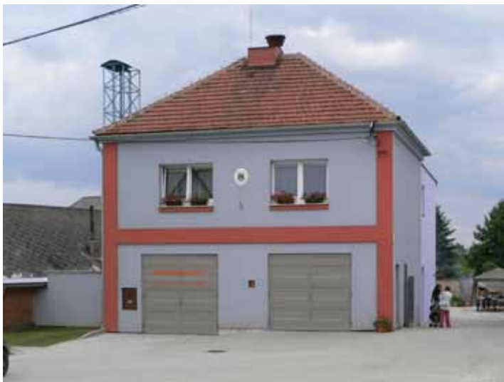
Obr. 13. Hasičská zbrojnice v současnosti
