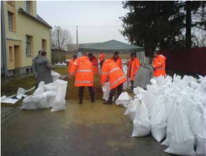
Obr. 23. Povodně Držovice rok 2006
