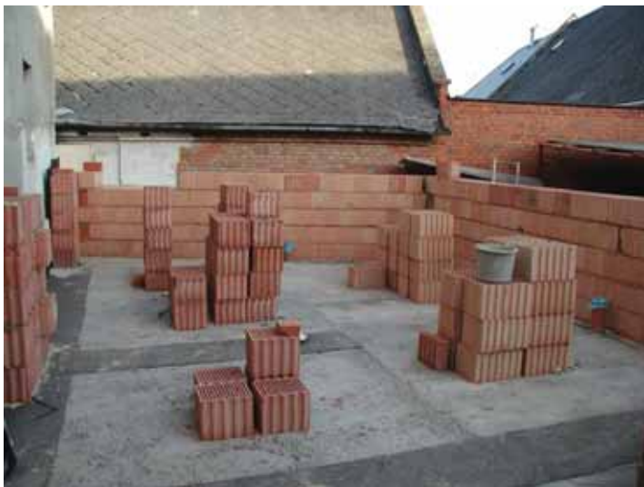
Obr. 39. Dostavba hasičské zbrojnice v roce 2004
