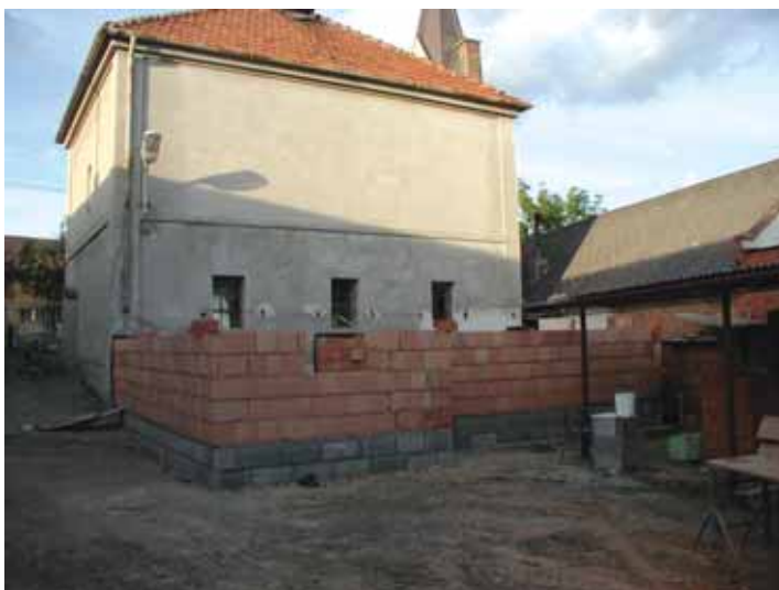
Obr. 38. Dostavba hasičské zbrojnice v roce 2004
